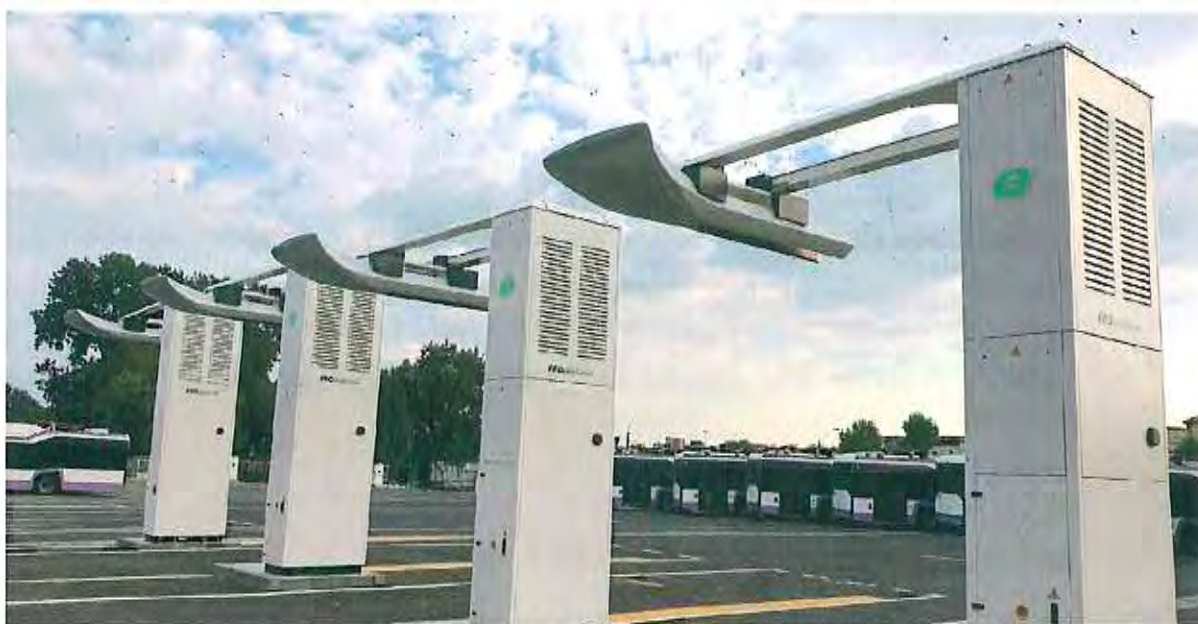
Figura 4.19. Infrastructură pentru încărcare rapidă, tip pantograph.
