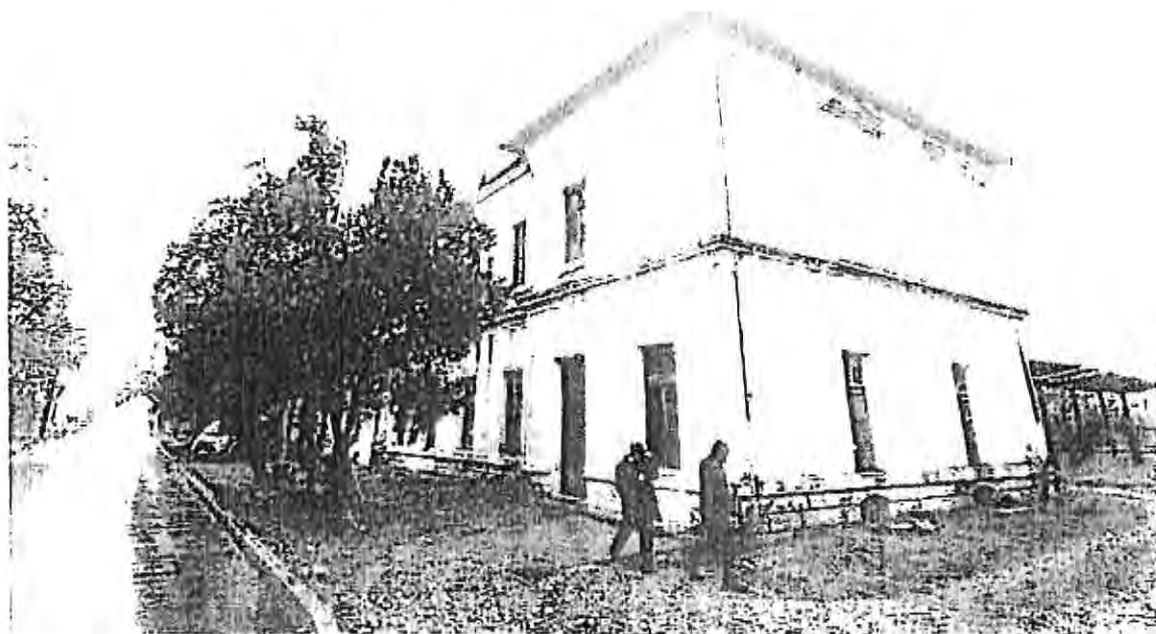
Fig.1: Fațada principală și fațadă lateral dreapta
