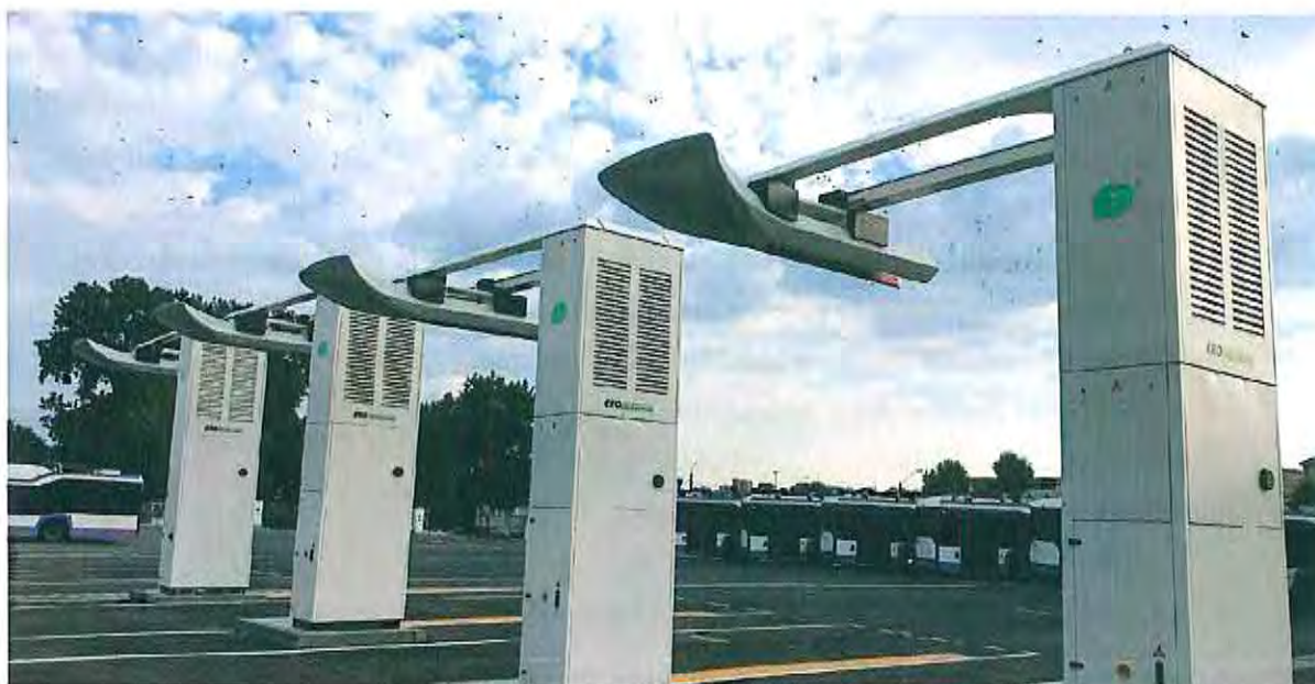
Figura 4.19. Infrastructură pentru încărcare rapidă, tip pantograph.
