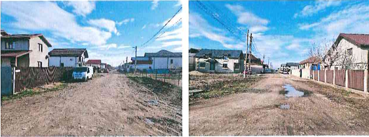
Figura 2.42. Străzi nemodernizate – cartier Bariera Focșani (exemplificare).
