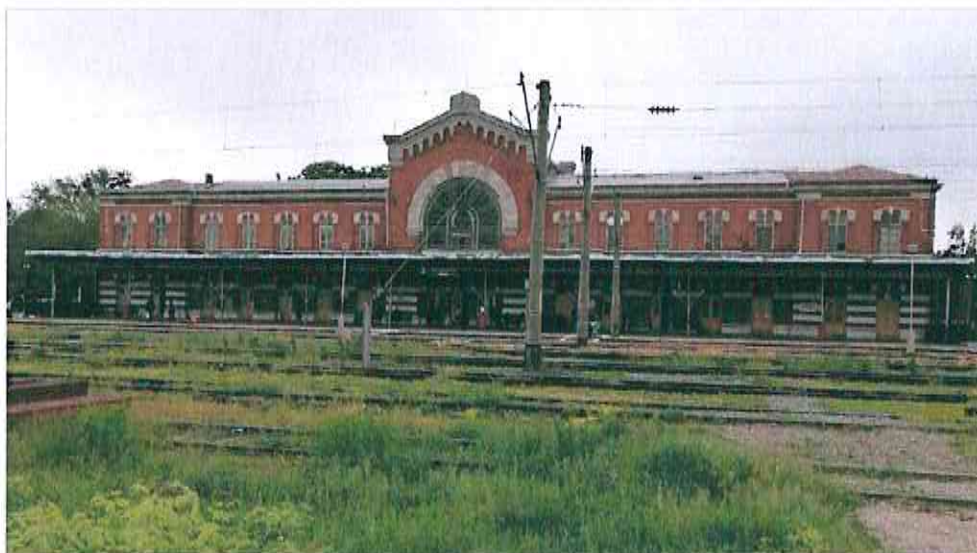
Figura 2.109. Stația de cale ferată Râmnicu Sărat.
