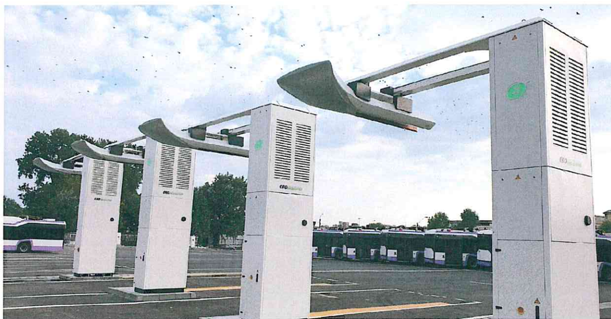
Figura 4.19. Infrastructură pentru încărcare rapidă, tip pantograph.
