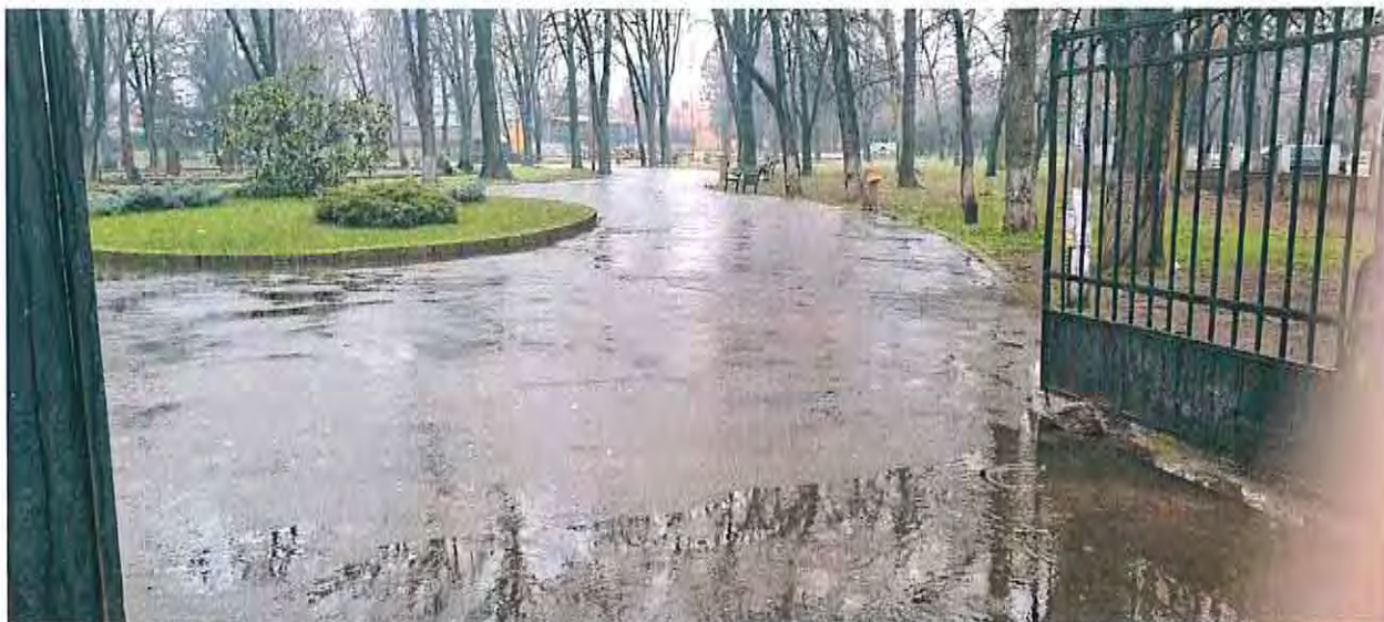
Acces str. N. Bălcescu, din zona Primăriei, scurgere deficitara a apei meteorice
