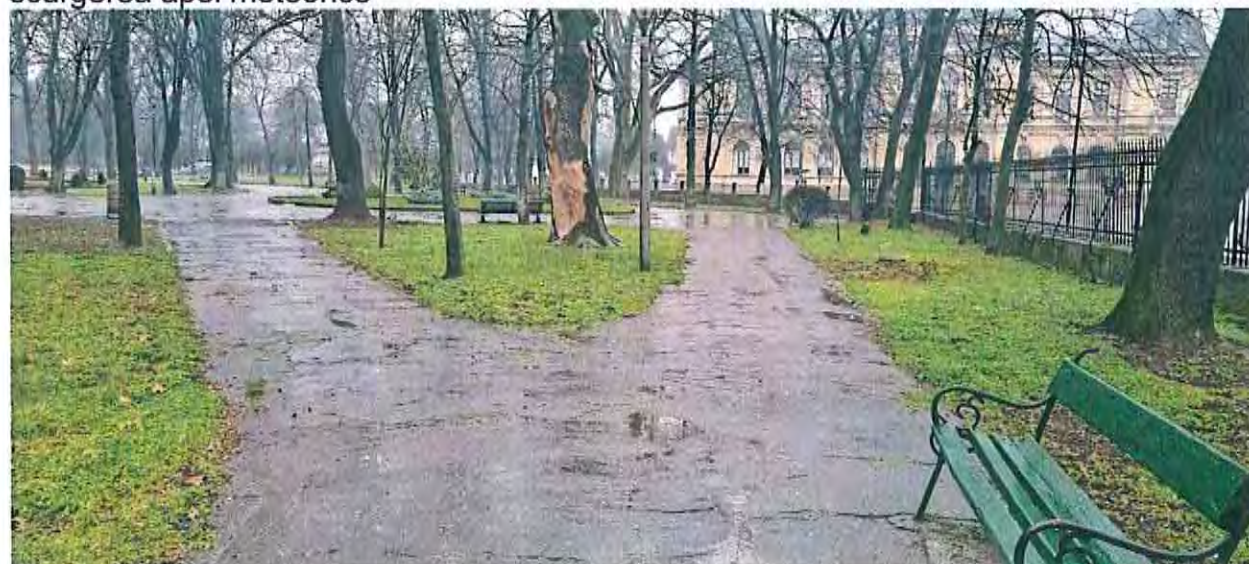
Stare generala asfalt degradata -faiantari, scurgere deficitara ape meteorice, lipsa borduri de incadrare
