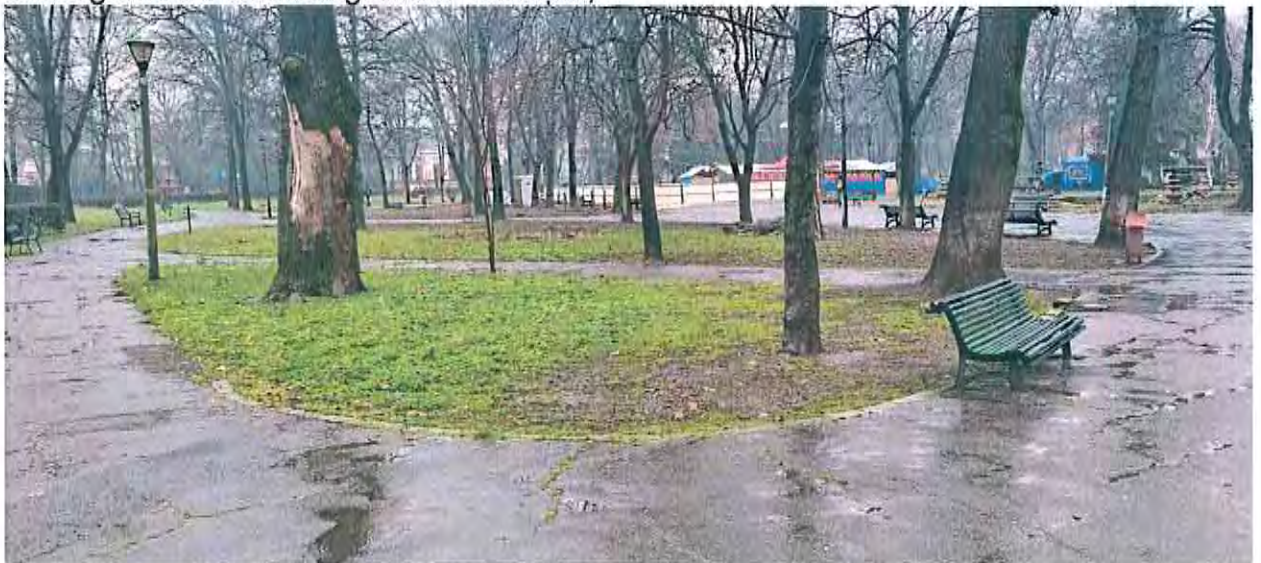
Stare generala asfalt degradata -faiantări,
