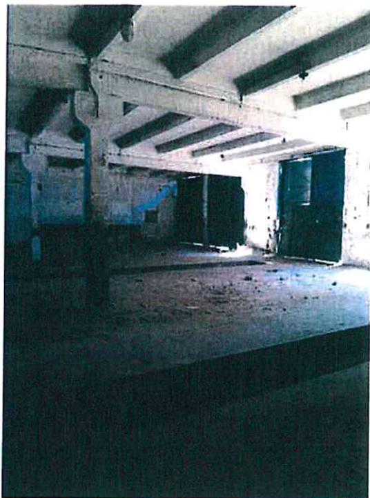
Foto 5 - interior, se observă degradări ale chesoanelor din cauza apei
