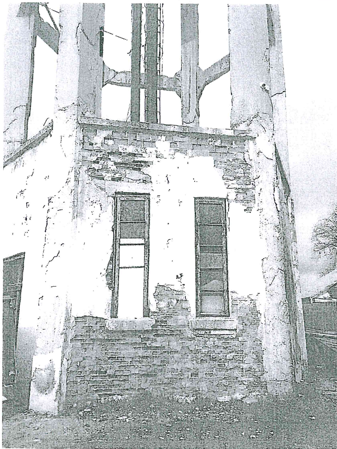
Foto 2 – Zidărie degradată, tâmplărie neetanșă, infiltrații de apă în structura pereților
