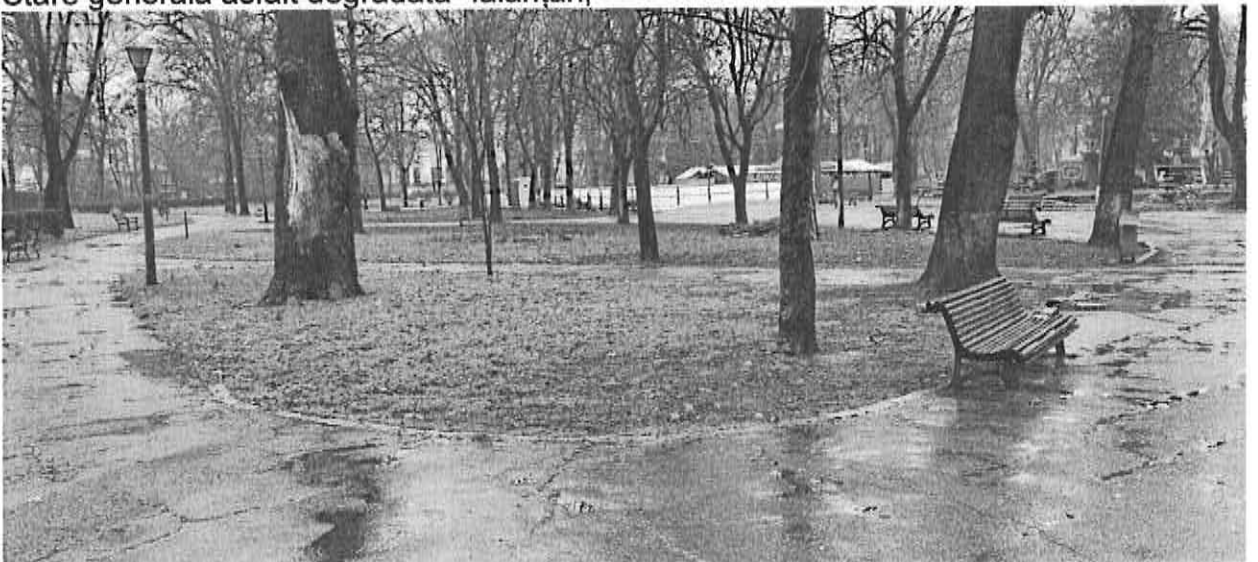
Stare generala asfalt degradata -faiantări,
