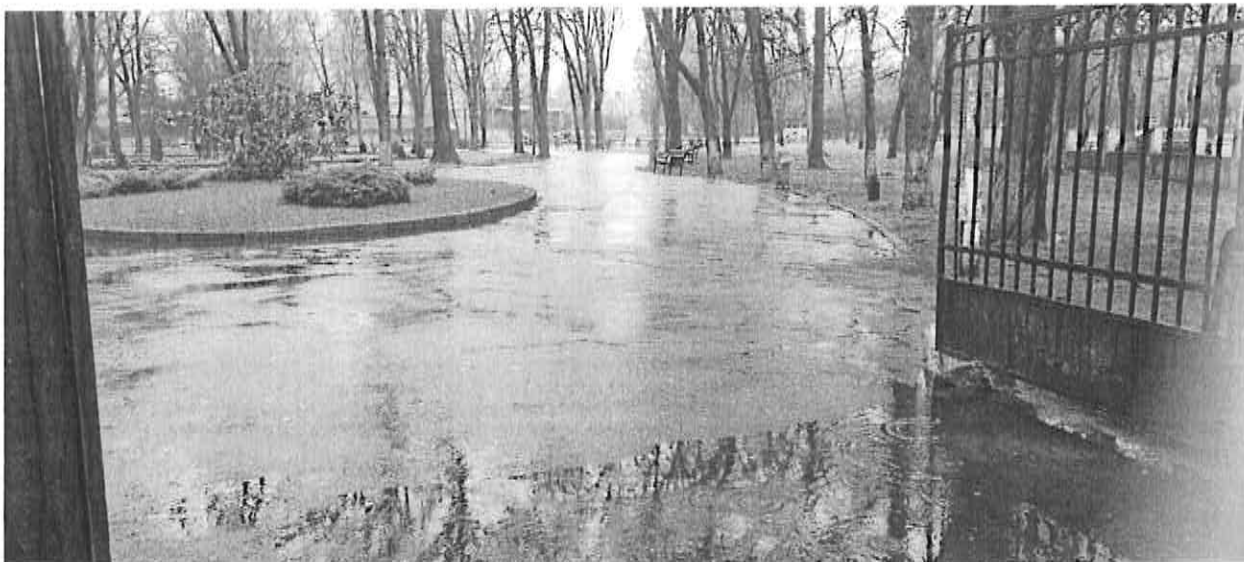
Acces str. N. Bălcescu, din zona Primăriei, scurgere deficitara a apei meteorice
