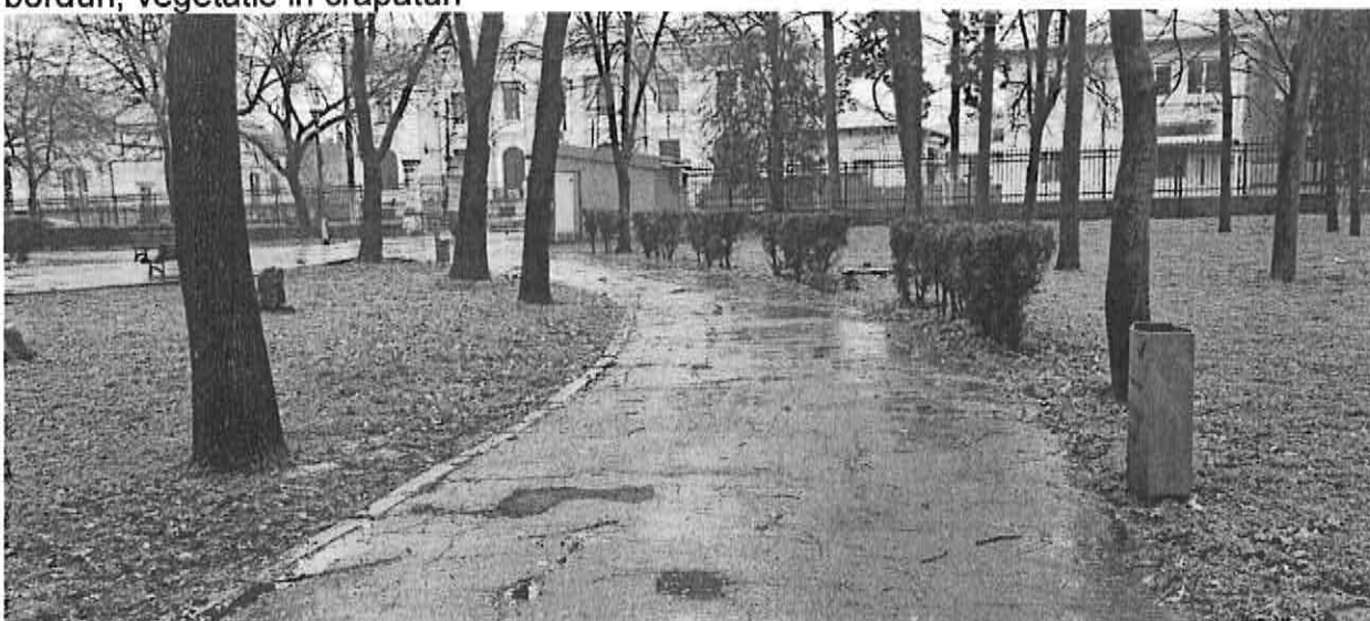
Stare generala asfalt degradata -faiantări,
