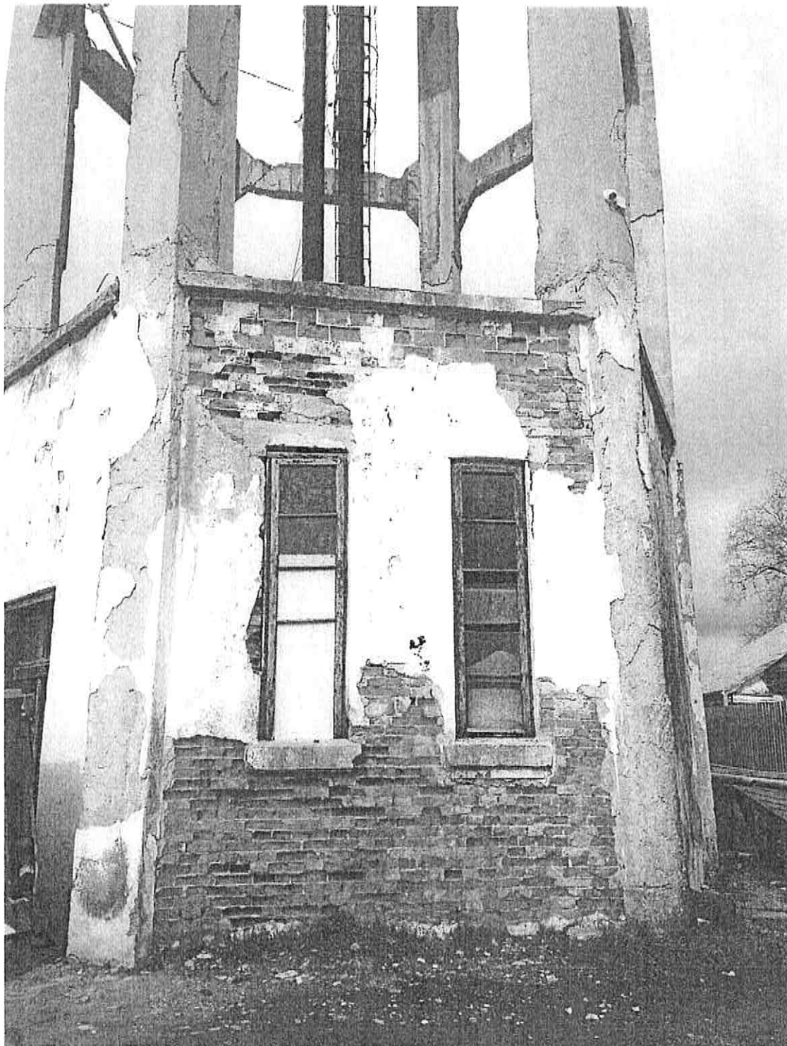
Foto 2 – Zidărie degradată, tâmplărie neetansă, infiltrații de apă în structura pereților
